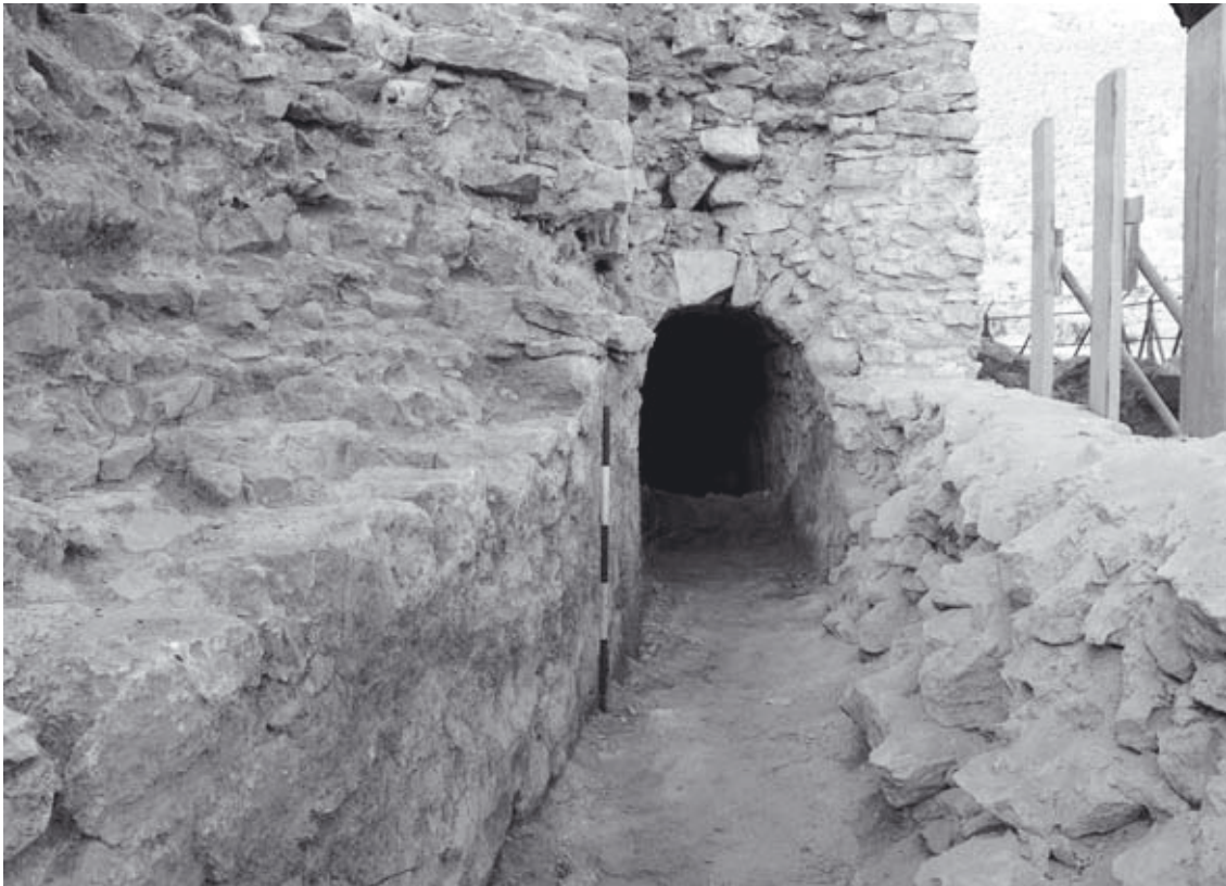
Abb. 315: ES1, Aristion-Leitung, Blick nach S
