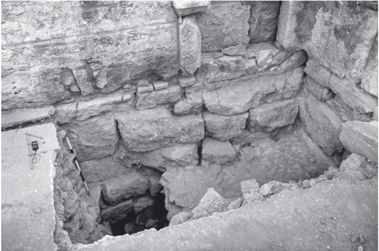
Abb. 285: Nördlicher Treppenaufgang, S 2/98, Oberfläche des Gussmauerwerks (2. Phase)
