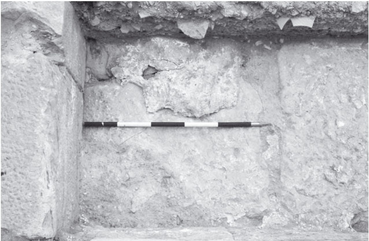
Abb. 360: Kammer KS2, Mörtelrest über Steinboden, von N
