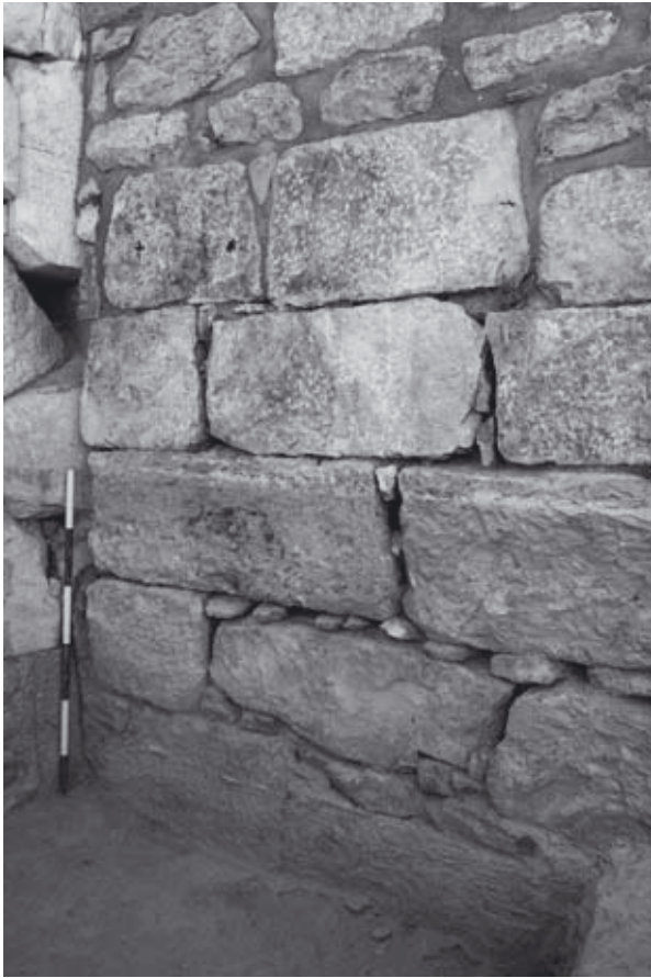
Abb. 272: KN1, vorgelagerte Süd-Mauer
