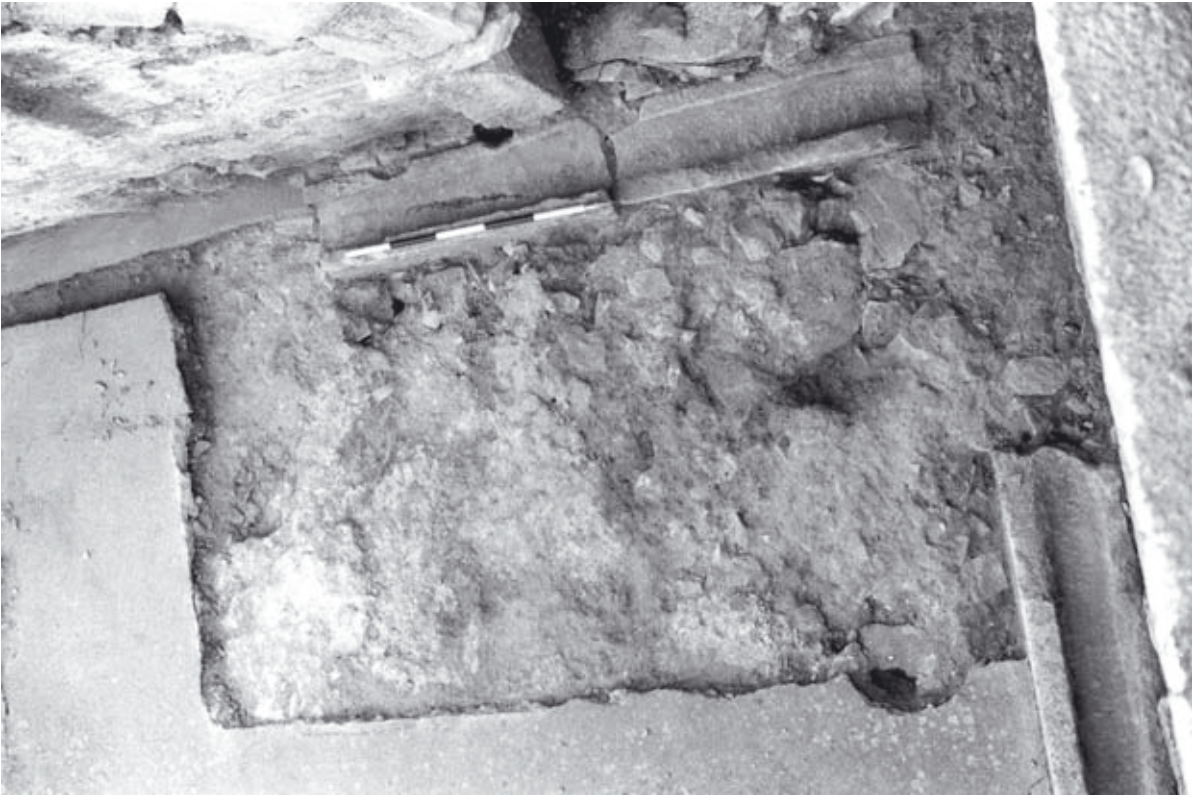
Abb. 284: Nördlicher Treppenaufgang, S 2/98, unterste stark vermörtelte Lage des Gussmauerwerks
