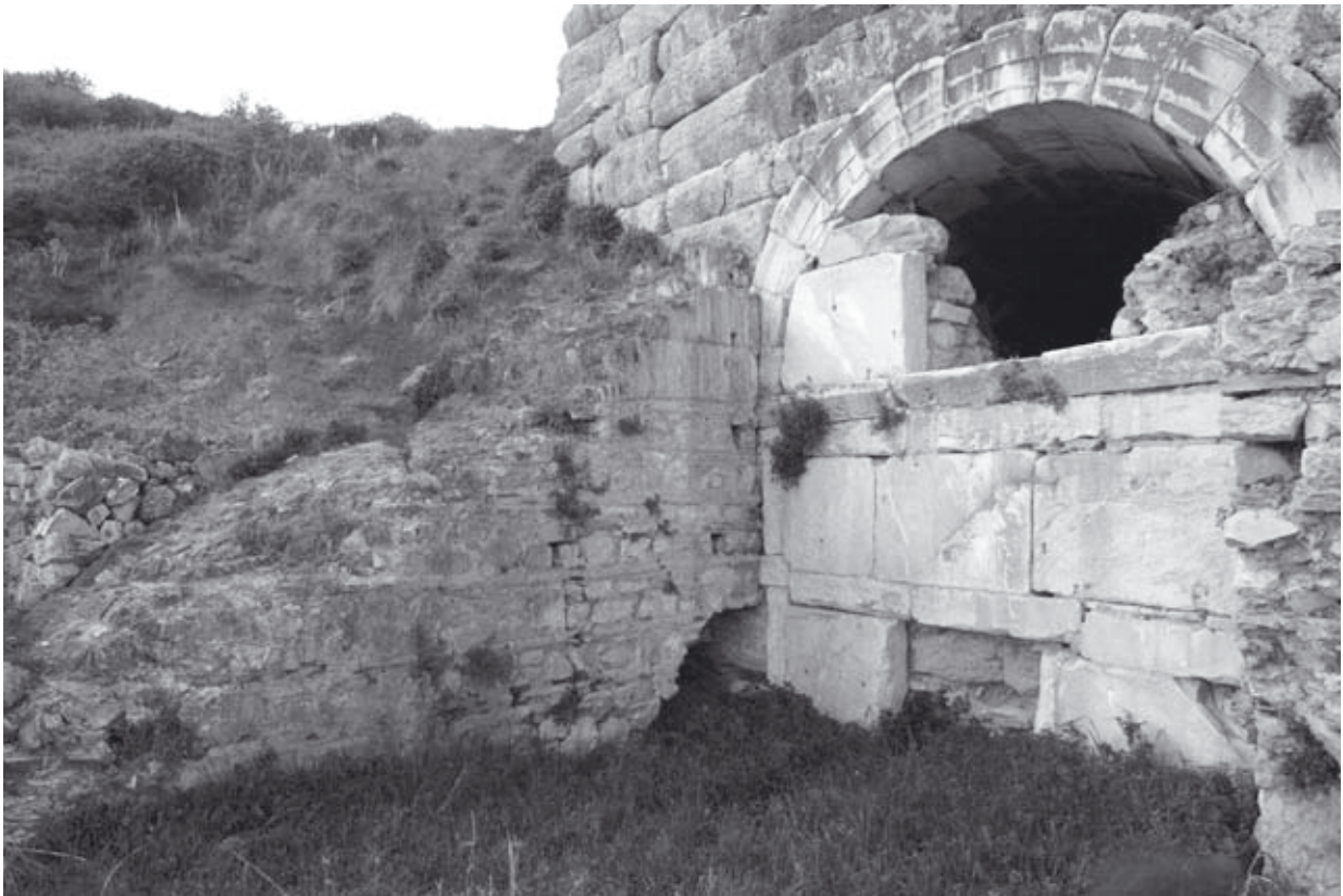
Abb. 299: EN2, Norden, östliche Stützmauer
