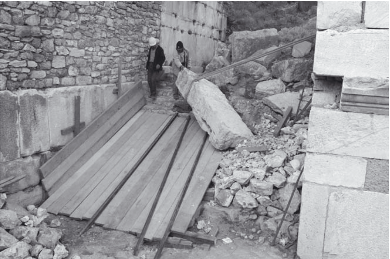
Abb. 345: vomitorium ES1-Süd, Bergung von Steinquadern aus den Schuttmassen (2006)
