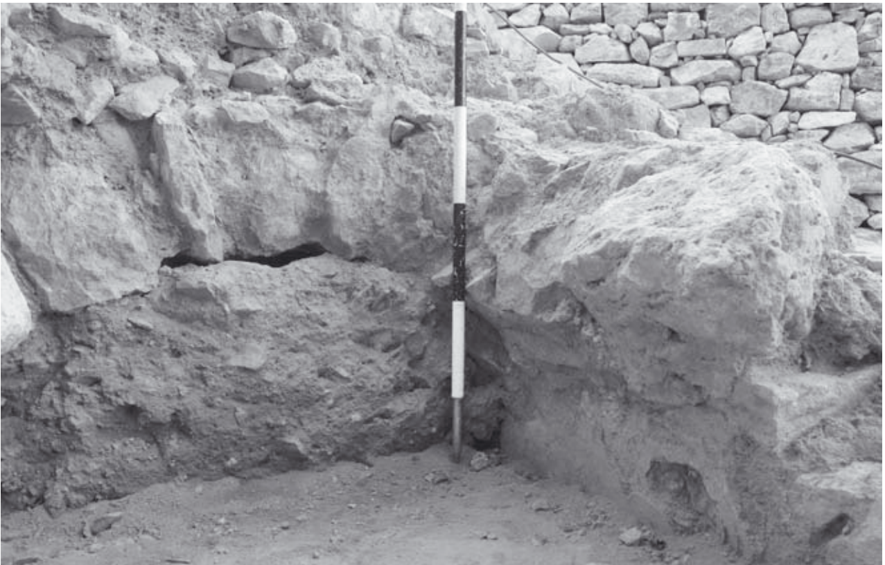
Abb. 337: Aristion-Leitung, bauliche Situation am Übergang zur Stiegengasse, Gewölbeansatz, von NO
