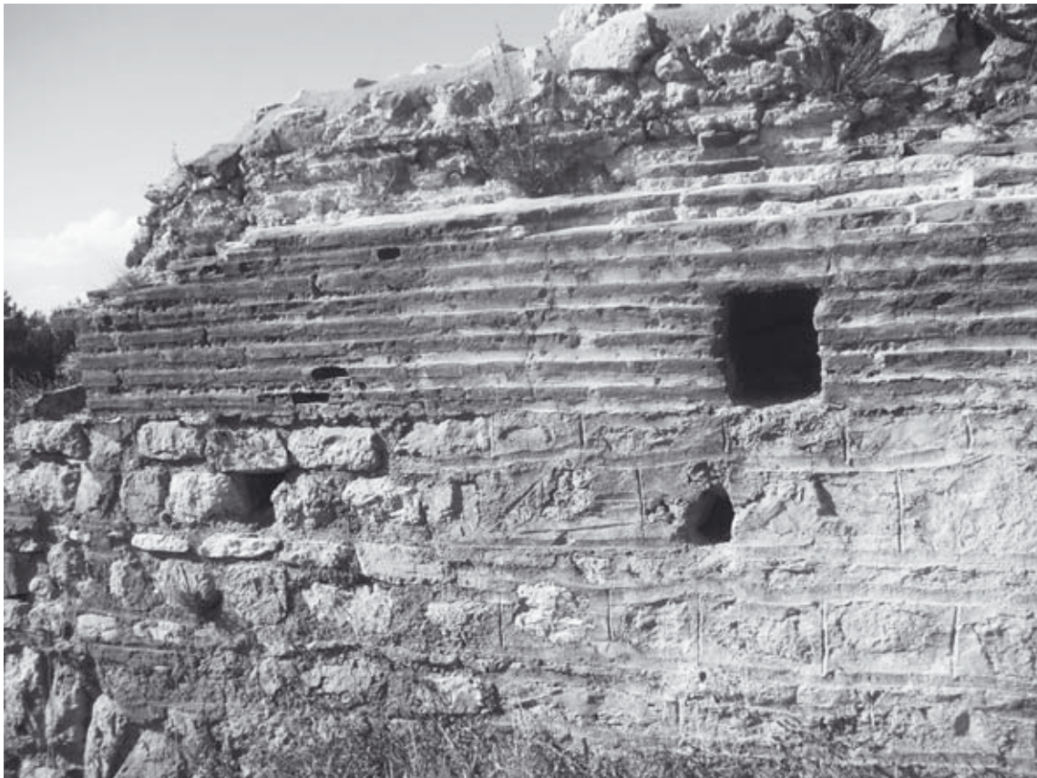
Abb. 274: KN3, vorgelagerte Nord-Mauer, Detail
