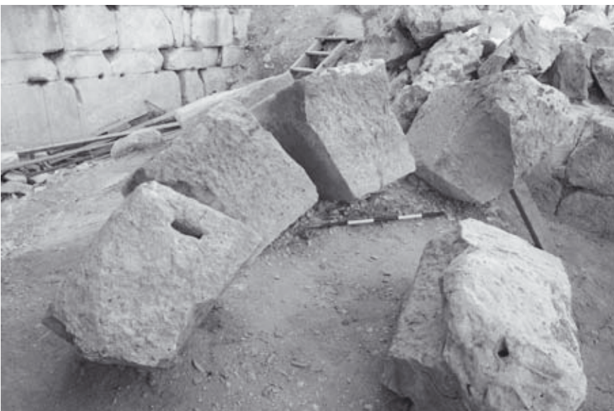
Abb. 355: Kammer KS1, verstärzte Gewölbesteine
