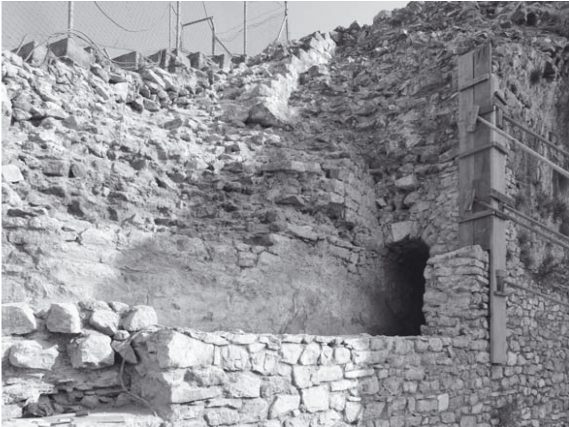
Abb. 314: ES1, nach Entfernung der Sicherung u. Beginn moderner Restaurierungen
