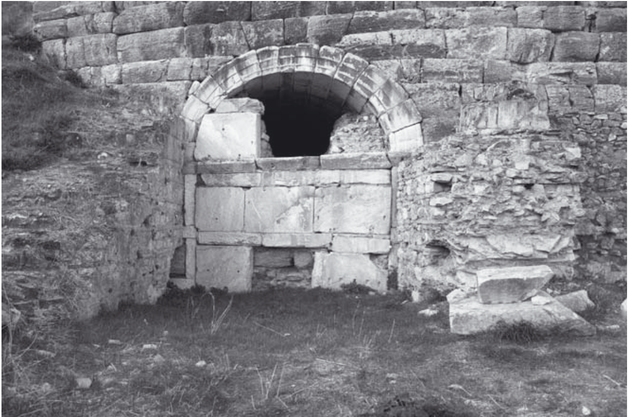
Abb. 294: EN2, Norden, Fassadenmauer N-Ansicht
