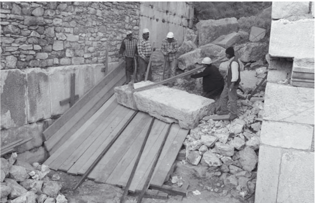
Abb. 346: vomitorium ES1-Süd, Bergung von Steinquadern aus den Schuttmassen (2006)
