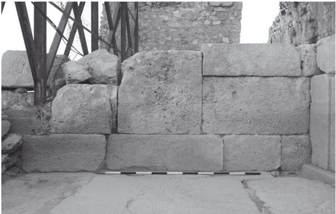
Abb. 367: Kammer KS2, Nordwand, Ansicht von S
