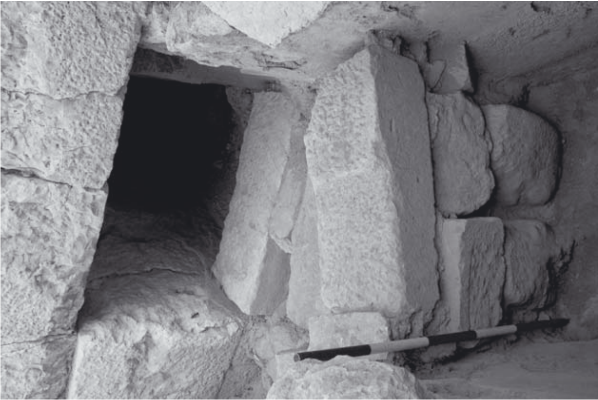
Abb. 339: Aristion-Leitung, bauliche Situation am Übergang zur Stiegengasse, Zusetzung, von S
