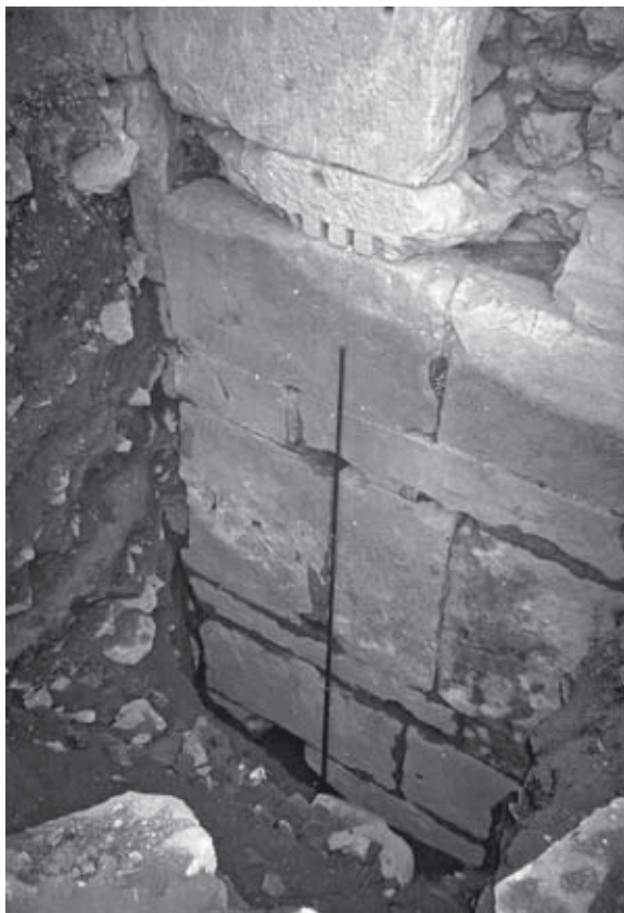
Abb. 297: EN2, Norden, S 5/98, Tiefsondage
