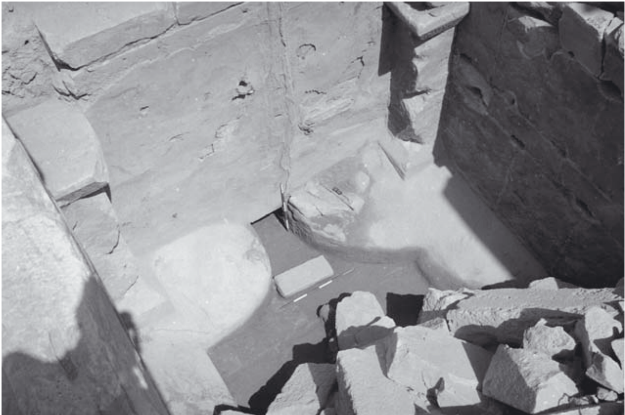
Abb. 257: EN1, Wasserverteiler, nördl. Bereich, S-Ansicht
