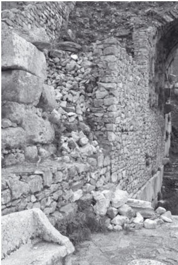
Abb. 311: ES1, Zustand der O-Wand (2006)
