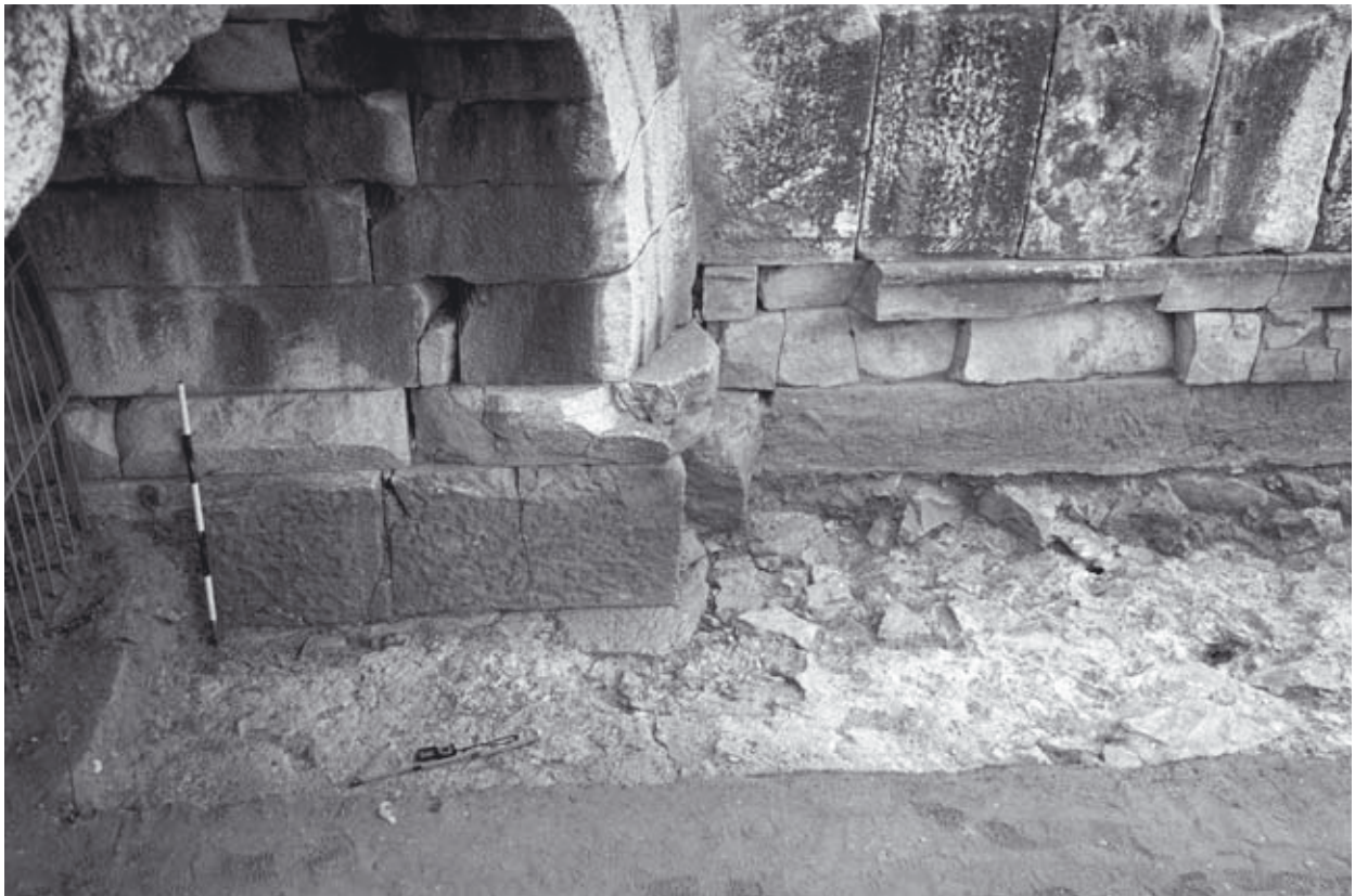
Abb. 288: EN2, Süden, S 4/98, Oberfläche des opus caementicium von W
