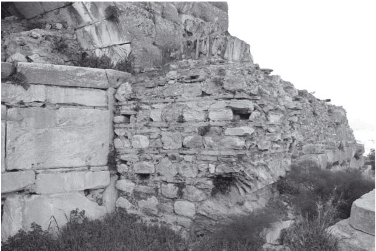
Abb. 300: EN2, Norden, westliche Stützmauer
