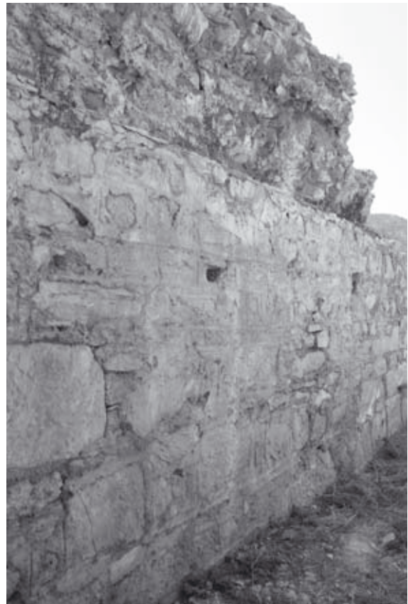
Abb. 277: KN2, vorgelagerte Süd-Mauer mit Fugenstrich
