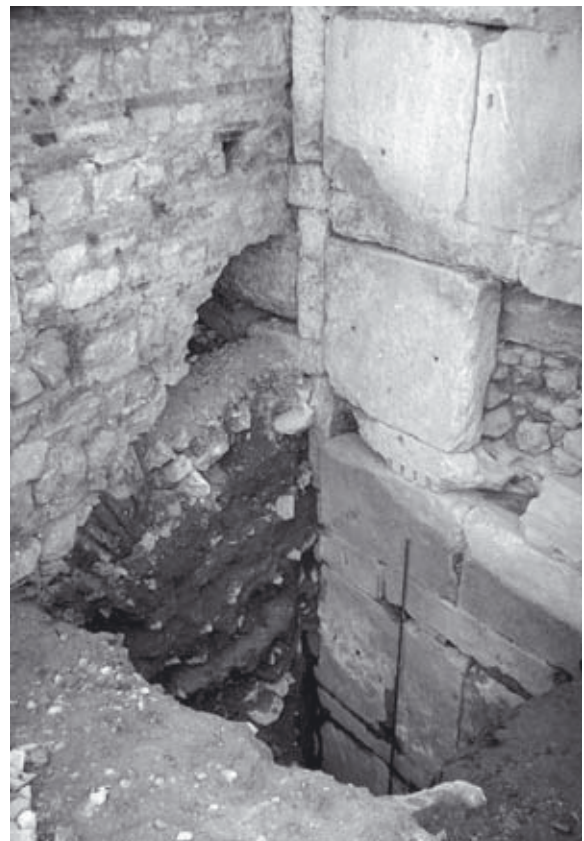
Abb. 298: EN2, Norden, S 5/98, Tiefsondage
